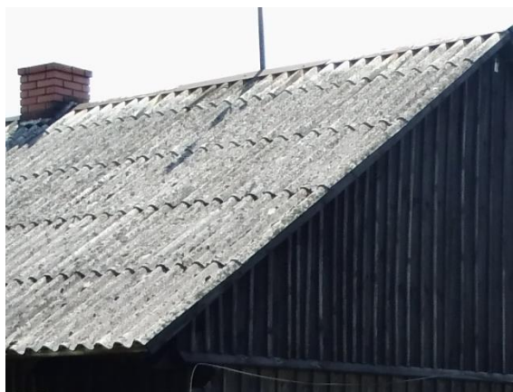
Rys. 1. Wyroby azbestowo – cementowe: po lewej płyty płaskie, po prawej faliste (źródło: materiały własne).
