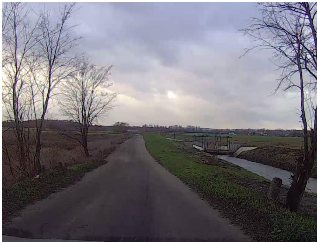
Zdjęcie nr 2. Droga z kruszywa wzdłuż rzeki Polki
