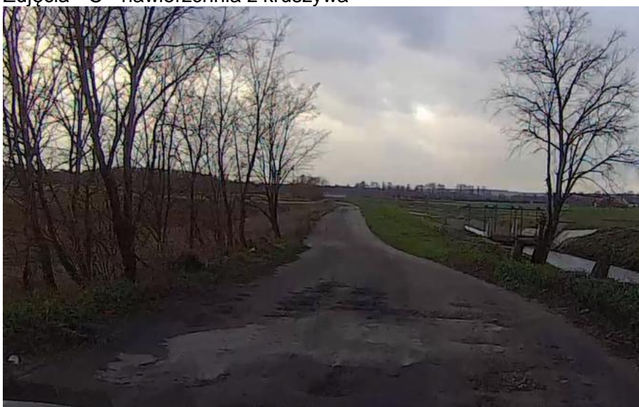
Zdjęcia - D - nawierzchnia z kruszywa
