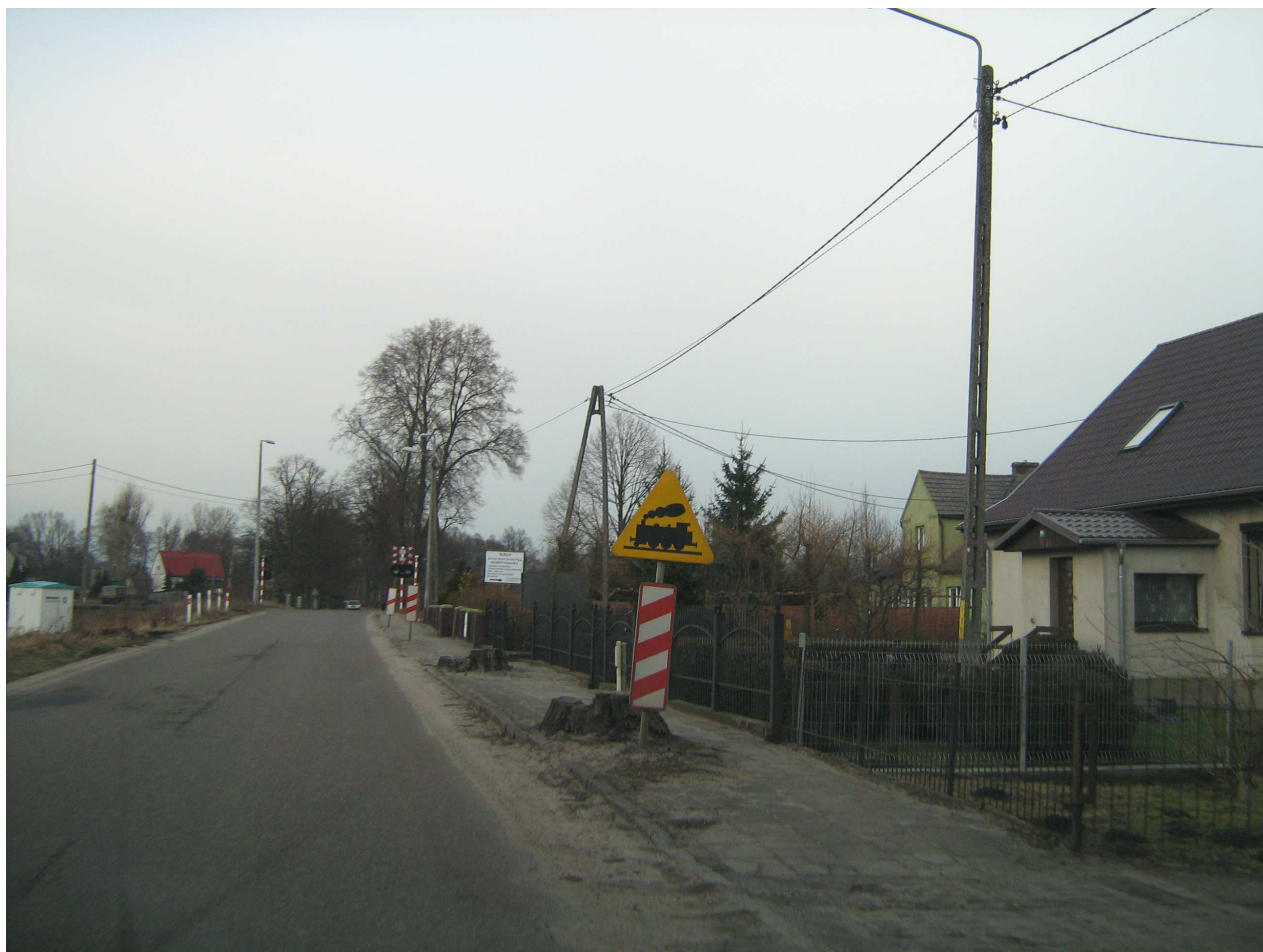
Zdjęcie nr 5 Początek opracowania widok przeciwnie do kilometracji.
