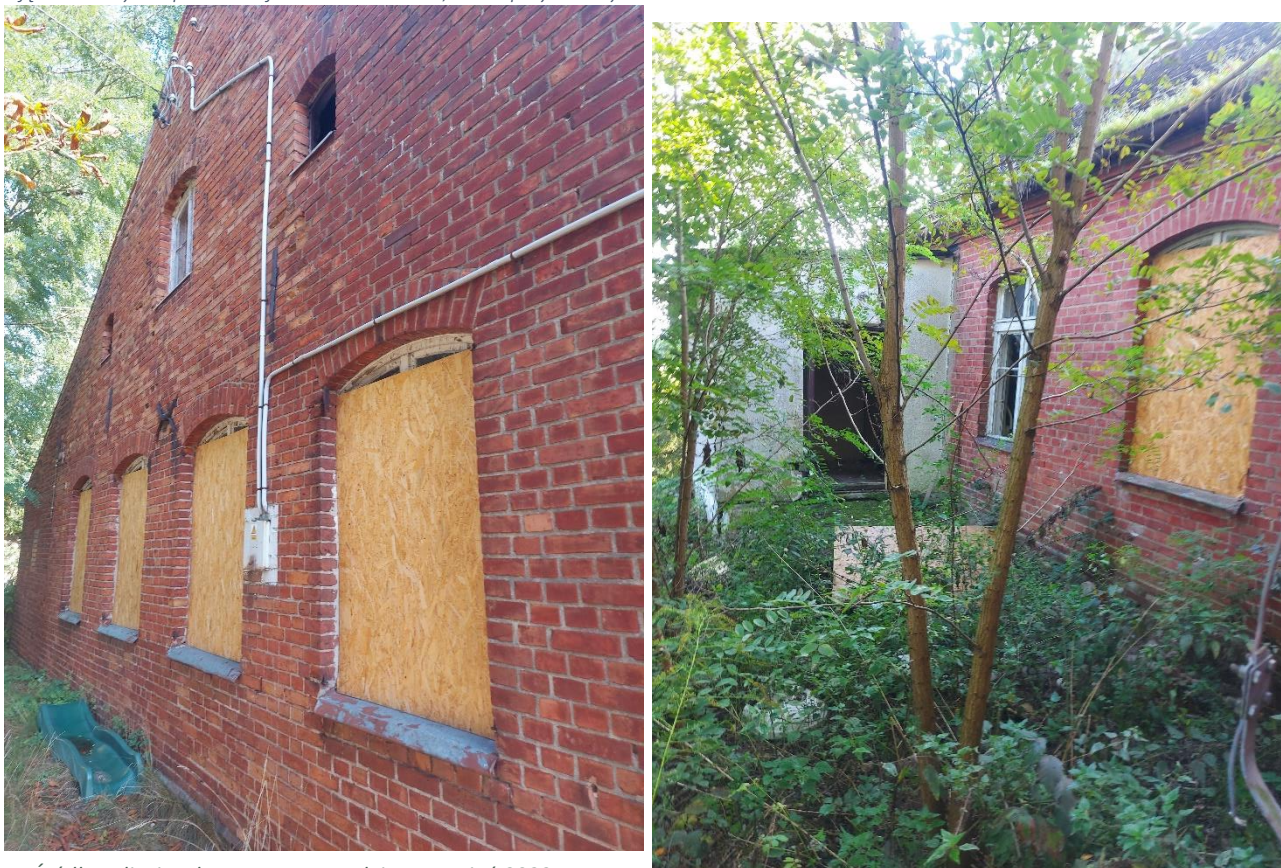
Zdjęcie 2 Budynek po dawnej szkole w Górecku, teren przyszkolny.
